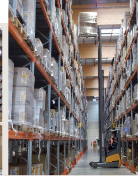
Das dritte Lagersystem besteht aus 13 Meter hohen Regalen. Die Gabelstaplerfahrer stellen die Paletten ebenerdig bereit.
